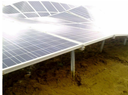
Ossature porteuse détruite et panneaux endommagés
