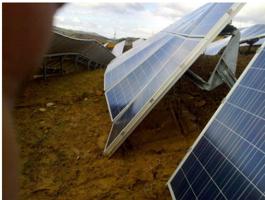
Ossature porteuse détruite et panneaux endommagés
